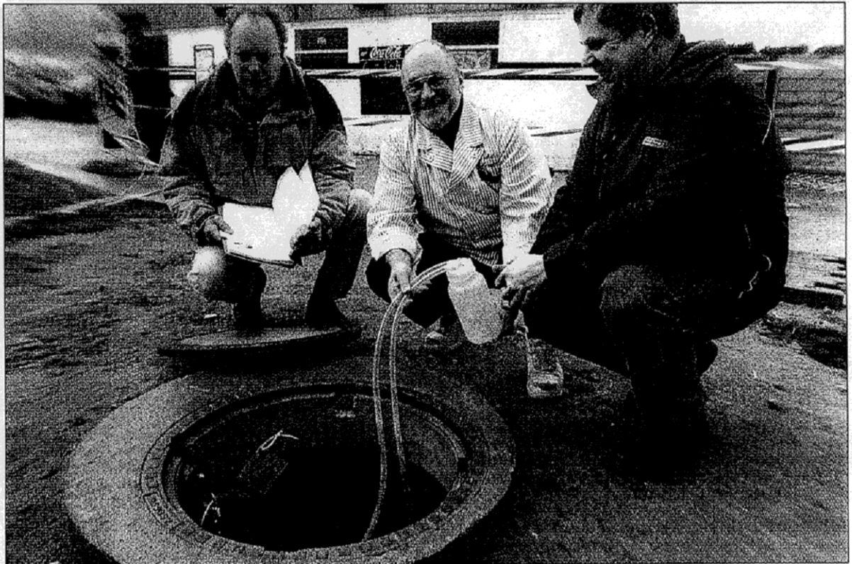
An der neuen wartungsarmen Anlage (v.l.): Udo Rähse (Kreis), Siegfried Schrempf und Thomas Scholten von der ETS. (Foto: Peter Oelker).
